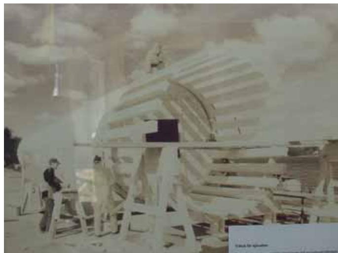
木质海水引入管道(1985 年)
